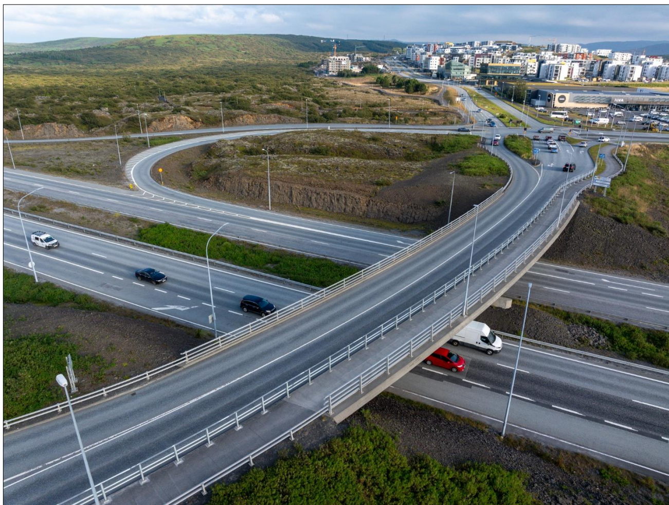
Vegrið við gangstétt á brú við Kaupþún yfir Reykjanesbraut.
