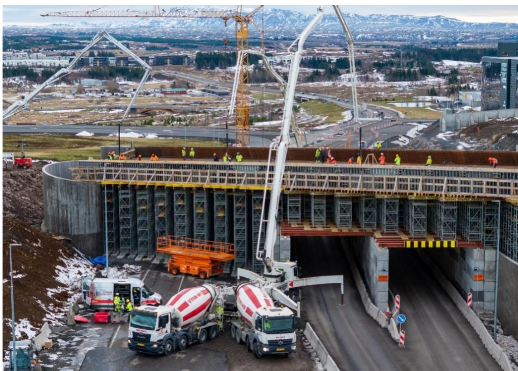
Vinna við nýja brú yfir Breiðholtsbraut sem tengjast mun Arnarnesvegi.
