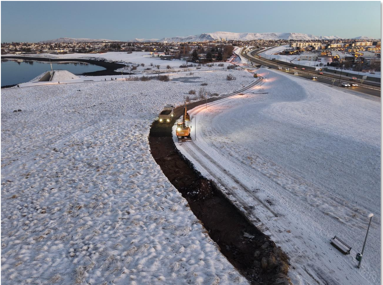
Framkvæmdir í Garðabæ, vestan við Hafnarfjarðarveg.
